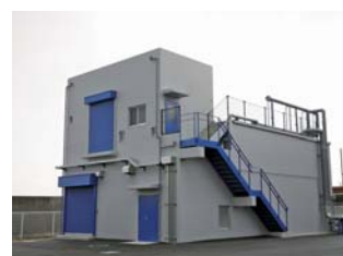
▲排水処理施設
