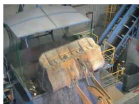
▲③破碎機投入口(限定公開)
