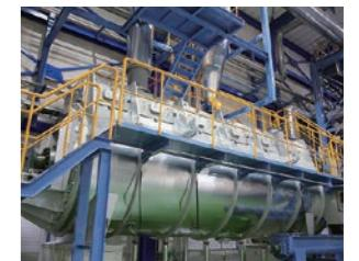
汚泥・動植物性残など有機性産業廃棄物のリサイクルプラントとしては阪神間最大級の処理能力(90.9m<sup>3</sup>/日)を保有。当社ではバイオマスボイラーや薬液洗浄装置の導入など、徹底した臭気対策を行うことで、都市型施設を実現しています。都市型施設は、顧客にとっては廃棄物の移動距離を最小限にし、廃棄物処理場への運搬にかかるコストとリスクを削減できるというメリットがあります。
