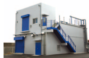
▲排水処理施設
