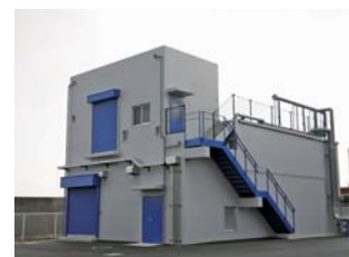
▲排水処理施設
