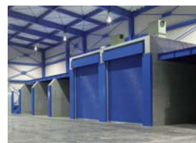
▲シャッター付保管ヤード
