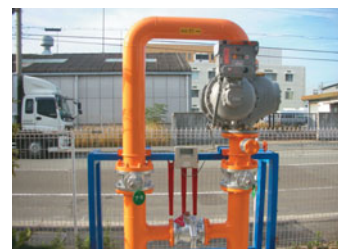
▲新設したガスのメーター Meter of newly established gas
